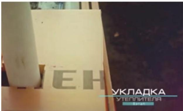
Уложить утеплитель по всей площади верха погреба и вокруг стенок на глубину промерзания, но не менее чем на 1 метр. Утеплитель закрепить с помощью монтажной пены или клейкой армированной ленты, как указано в *Приложениях*. Толщина слоя утеплителя должна составлять не менее 100 мм. Горловина утепляется аналогично. Стыки и полости в утеплителе заполнить монтажной пеной. Трубы вентиляции, находящиеся в грунте, утепляются вспененным теплоизолятором для труб, толщиной не менее 100 мм.
