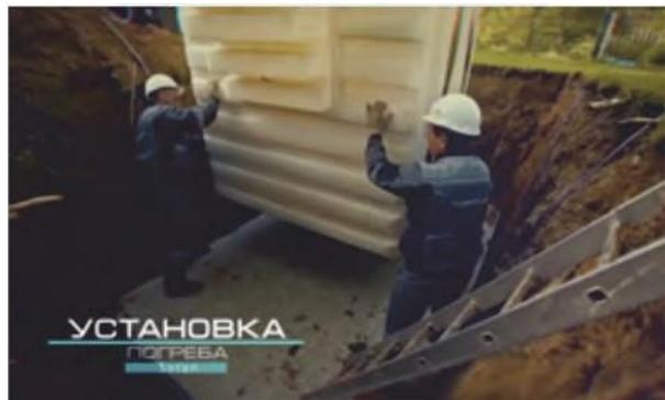
С помощью спецтехники опустить погреб в котлован, и выровнять его относительно бетонной плиты и тросов. Выставить погреб по уровню.
